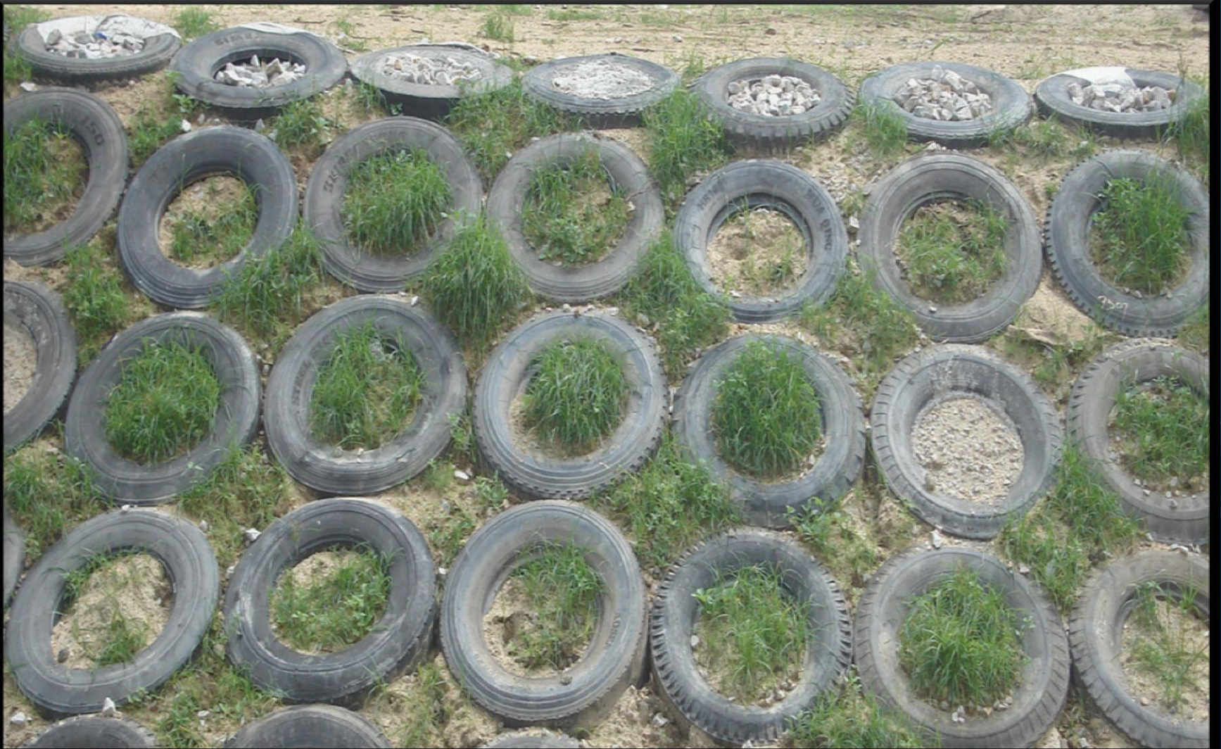
Gambar 9 – Keadaan T-Best Selepas Air Surut Air Pada Januari 2014 Hingga Sekarang
