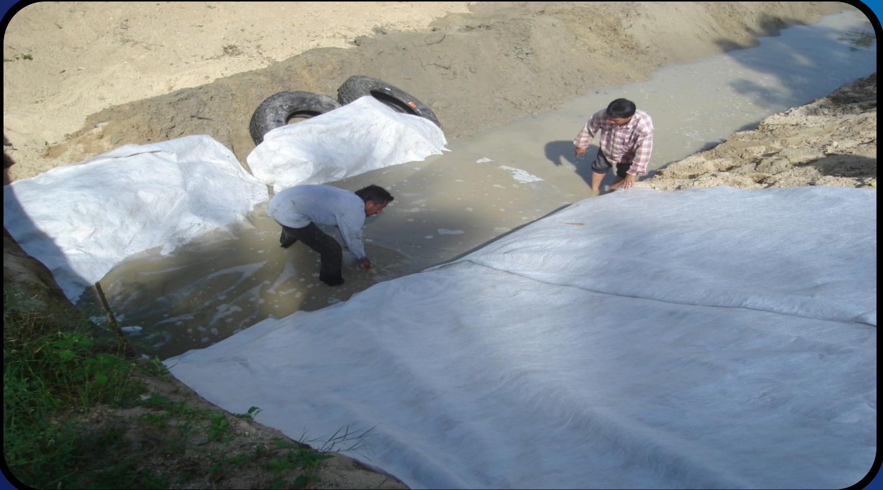
Gambar 2 – Kerja Menghampar Geotextile
