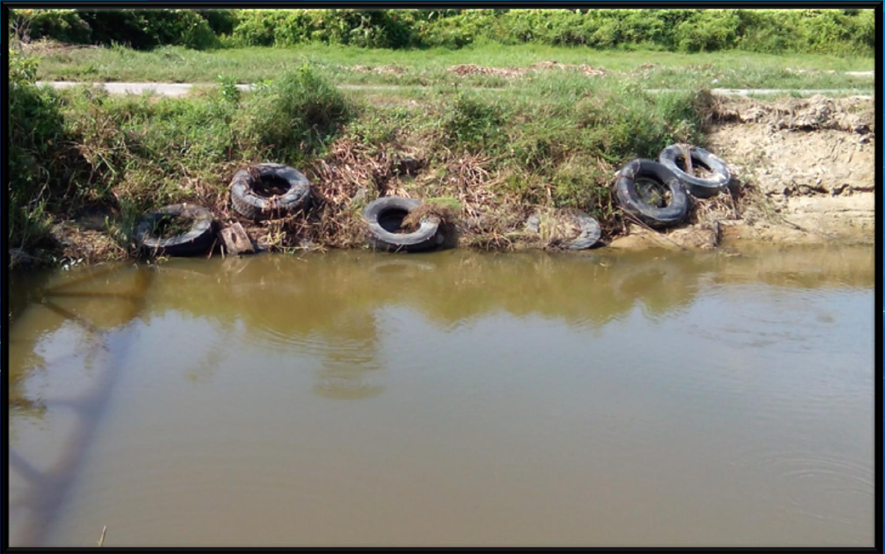
Gambar 5 – Keadaan Tayar Selepas Mengalami Hujan Lebat & Paras Air Tinggi Serta Arus Yang Deras Pada Disember 2012
