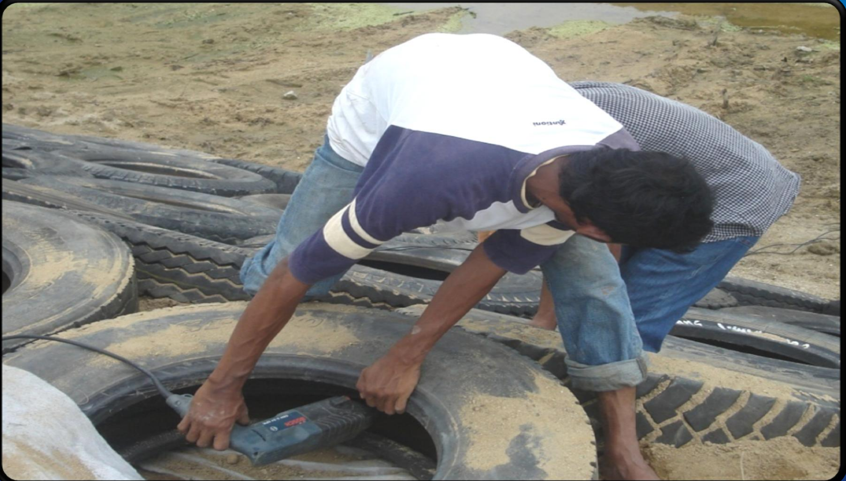
Gambar 3 – Kerja Menyusun Tayar Dan Memasang Bolt & Nut
